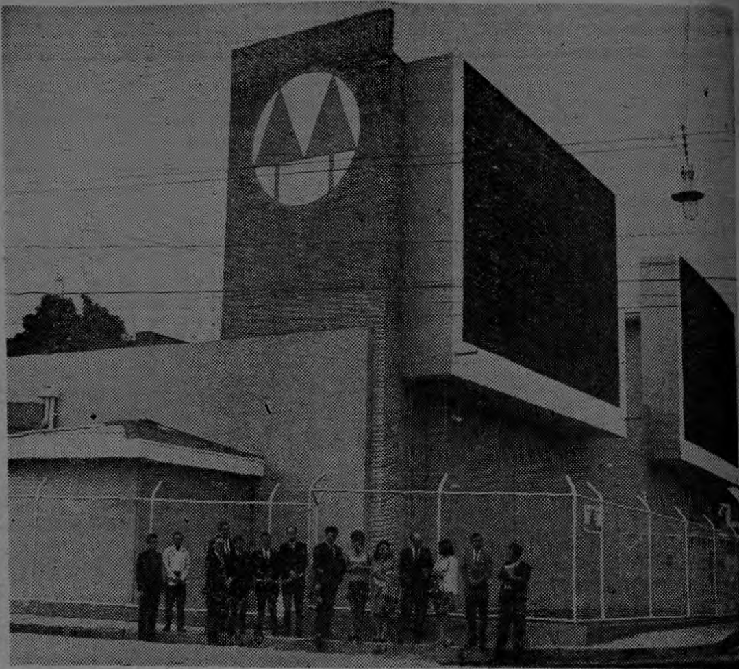
Frente a la nueva planta de helados, vemos al Gerente de la Empresa, Ing. Rafael Enrique Montero Castro, conversando con nuestra redactora, Inés de Steffen. Periodistas de otros medios de comunicación colectiva y personeros de la Dos Pinos aparecen en el grupo que recorrió las instalaciones. En la parte superior del edificio están las unidades de difusión del frío.
